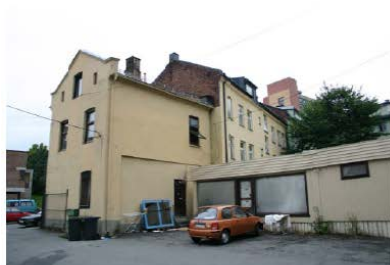
Smedgata 25 A, fasade mot bakgård, samt kontorbrakke.
