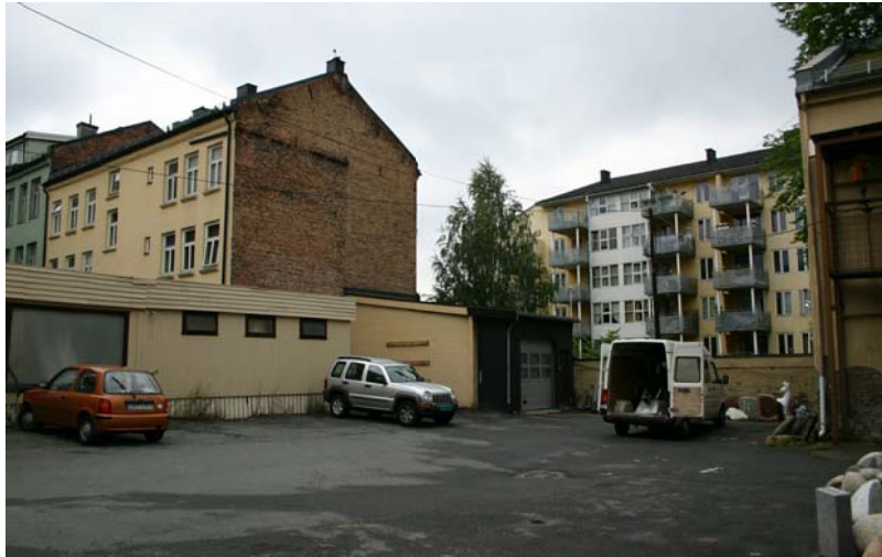
Eksisterende bebyggelse i bakgård - kontorbrakke samt garasje
