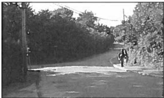
Siktlinjene i krysset mellom Bygdøynesveien og Admiral Børresens vei er ikke i henhold til Håndbok N100 fra Statens vegvesen
