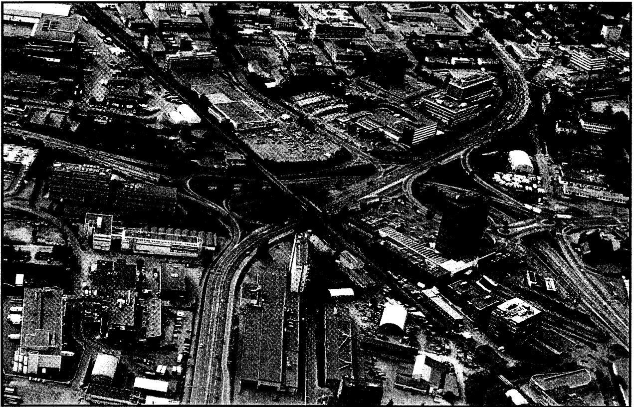
Økernkrysset sett fra sørøst. Hovedveiene Ring 3, Østre Aker vei og Økernveien møtes her. Alnabanan går i bro over kryssoområdet, T-banen går i kulvert under. Høyhuset på Økernsenteret ses til høyre i bildet. Bildecopyright: Mapaid AS.
