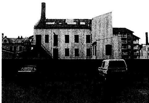
Verkstedsbygning sett fra vest, Marstrandgt. 6
