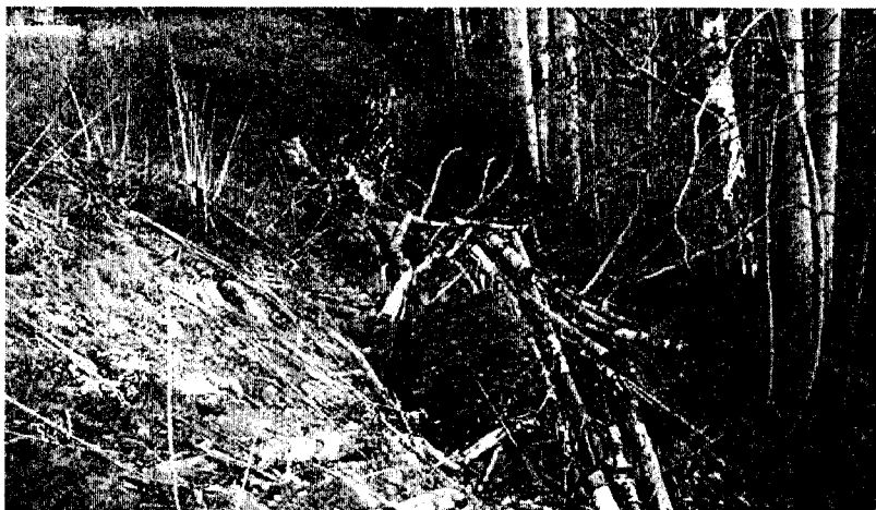
Bekkegrøft med store mengder kvist og søppel. Foto: Øystein Røsok.
