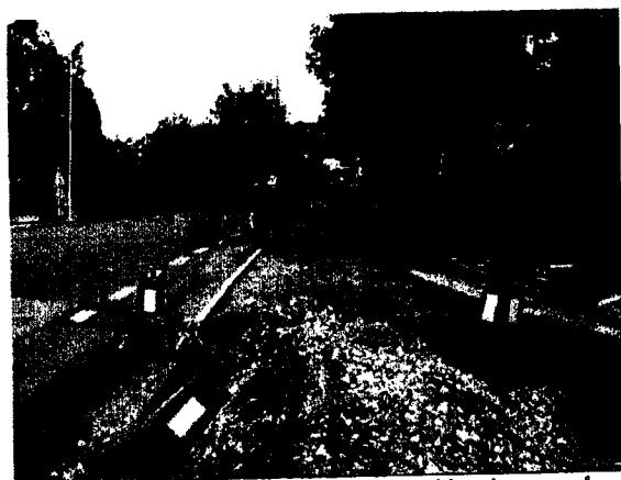
*Fotgjengeren benytter sykkelfeltet og kjørebanen på grunn av gravearbeid. Sikringen av anlegget er mangelfull. Foto: Samferdselsetaten*
