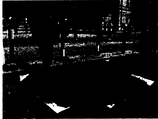
På grunn av anleggsarbeider i Stortingsgata ble fotgjengerne ledet til å krysse kjørebane ved holdeplass. Høydeforskjellen mellom kjørebane og holdeplassareal er uakseptable som gangsoner. Ved hjelp av enkle grep er krysningspunktet gjort midlertidig tilgjengelig for alle. Foto: Samferdselsetaten.
