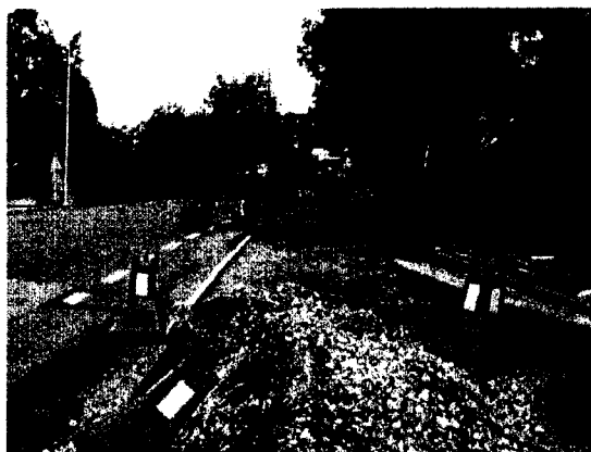
Fotgjengeren benytter sykkelfeltet og kjørebane på grunn av gravearbeid. Sikringen av anlegget er mangelfull. Foto: Samferdselsetaten
