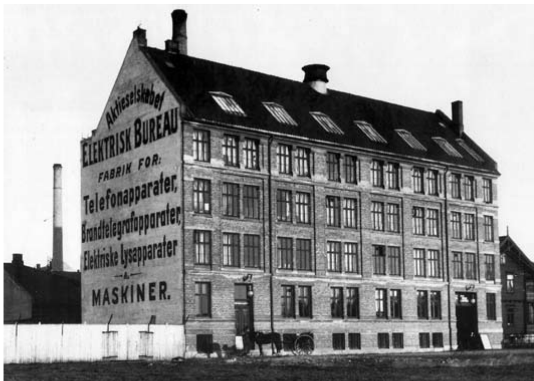
Middelthuns gate 17. Ble bygget av Elektrisk Bureau i 1896.
