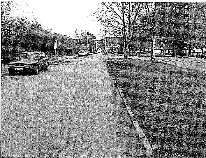
Stavangergata ved krysset med Sarpsborggata.
