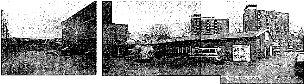
Fra stikkveien mellom Stavangergata og Voldsløkka. Hafslunds trafo til venstre. På øverste bilde ses Margarinfabrikken.
