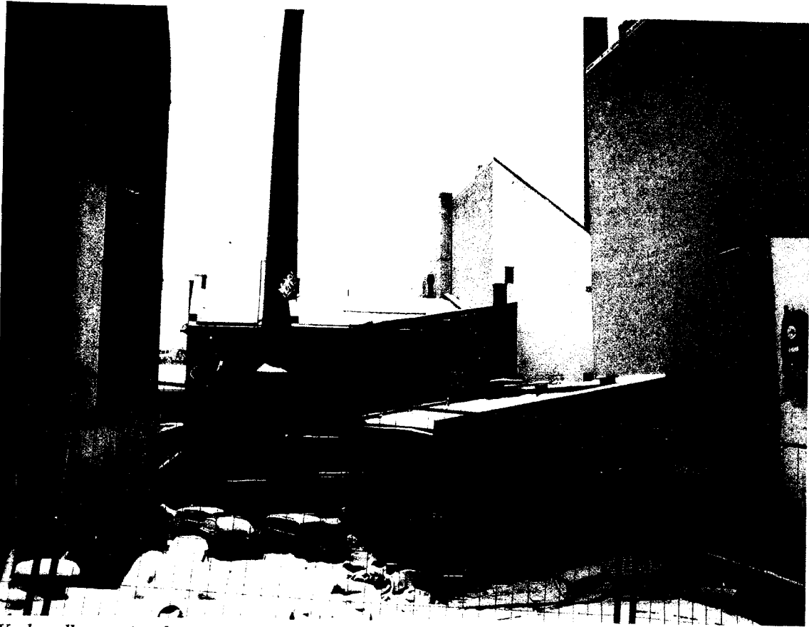
Verkstedbygget i syd sett fra Korsgata, med antydning av volumet av det ene tilbygget som planforslaget åpner for. Her sees også at øvre del av eksisterende pipe ikke er i lodd.
