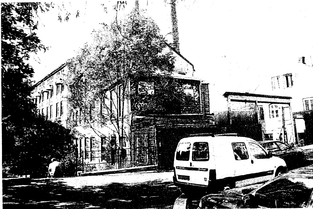
Verkstedbygget i syd sett fra Torvbakkagata, med antydning av volumene av de tilbyggene som planforslaget åpner for. Eksisterende garasje bak gjerdet kan erstattes av nybygg, men veggen mot gaten må fortsatt være panelt som i dag.
