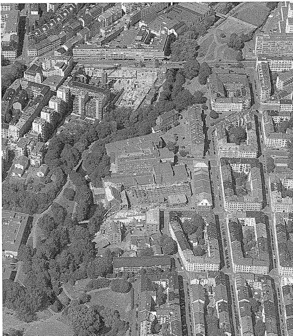
Store elvekorridorer som Akerselva er viktige ventilasjonskanaler i byggesonen.
