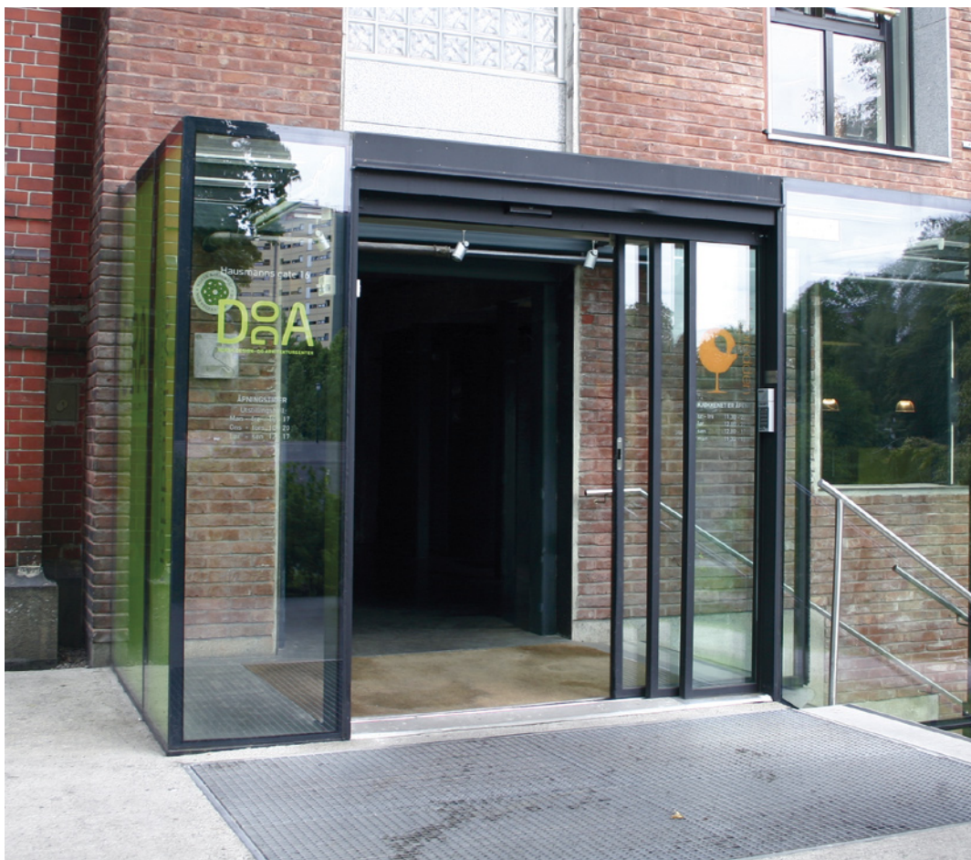
DogA - Norsk Design- og Arkitektursenter. Arkitekt: Jensen og Skodvin Arkitektkontor, 2004. Bruksendring av transformatorstasjon med trappefri atkomst og automatisk døråpning gir god tilgjengelighet for alle.
