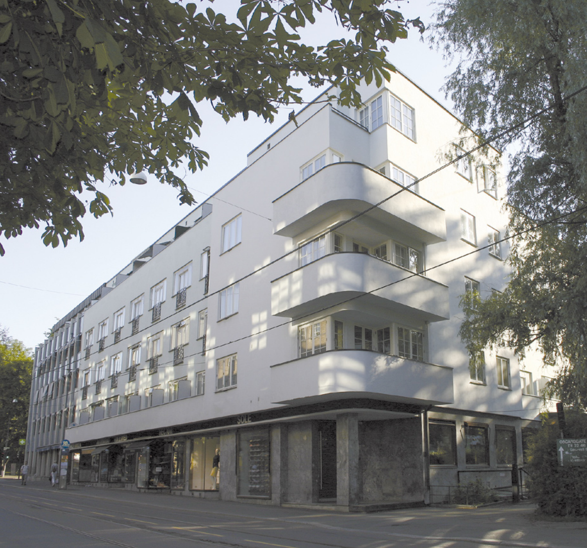
Oppgradering av Apotekerbygningen, Oscarsgt. 19 i bydel Frogner. Oppført 1939, arkitekt Frost & Sandved.
