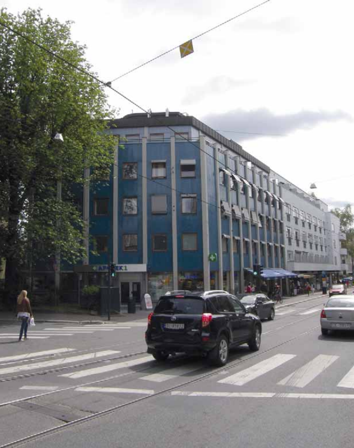
Oppgradering av Apotekerbygningen i bydel Frogner.
