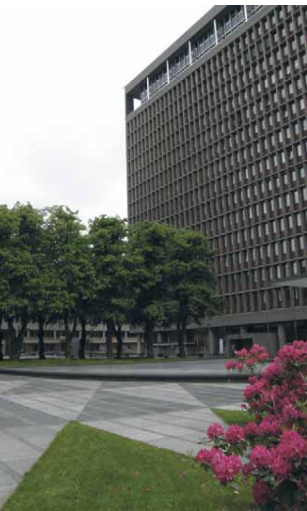
Regjeringskvartalet er oppført i fem byggetrinn i perioden 1958 – 96. Naturbetong ble her brukt for første gang. Arkitekt: Erling Viksjø.
