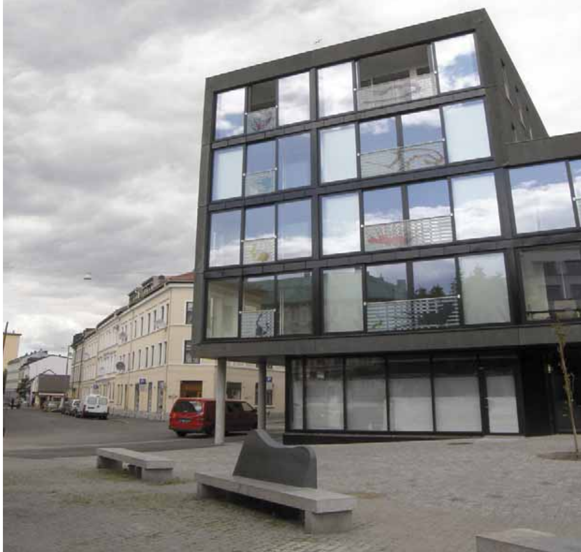
Platous gate 26, infill av boliger i kompleks bymiljø med bl.a. takhage og dobbel glassvegg. Arkitekt: Element arkitekter as, Snøhetta as, kunstnerisk utsmykking Pia Myrvold, 2009
