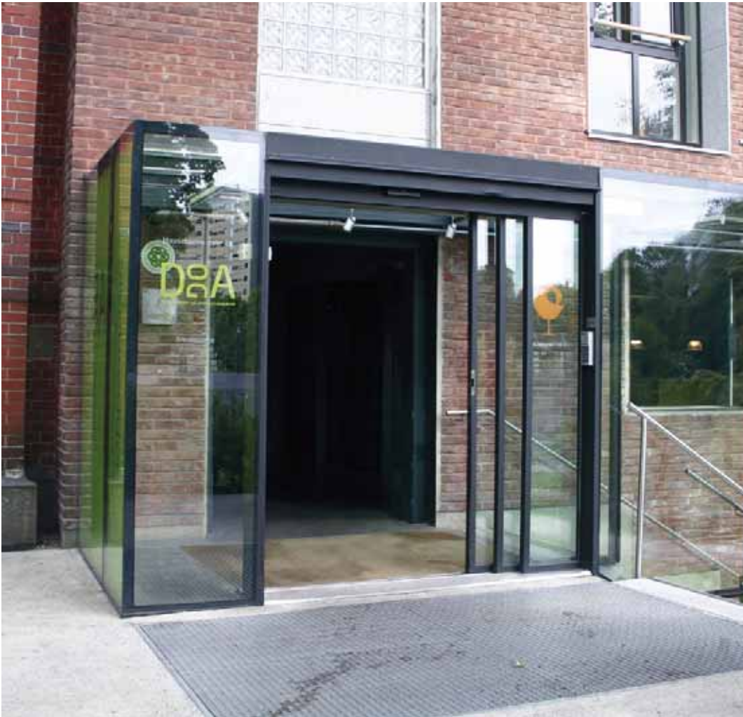
DogA - Norsk Design- og Arkitektursenter. Arkitekt: Jensen og Skodvin Arkitektkontor AS, 2004. Bruksendring av transformatorstasjon med trappefri atkomst og automatisk døråpning gir god tilgjengelighet for alle.
