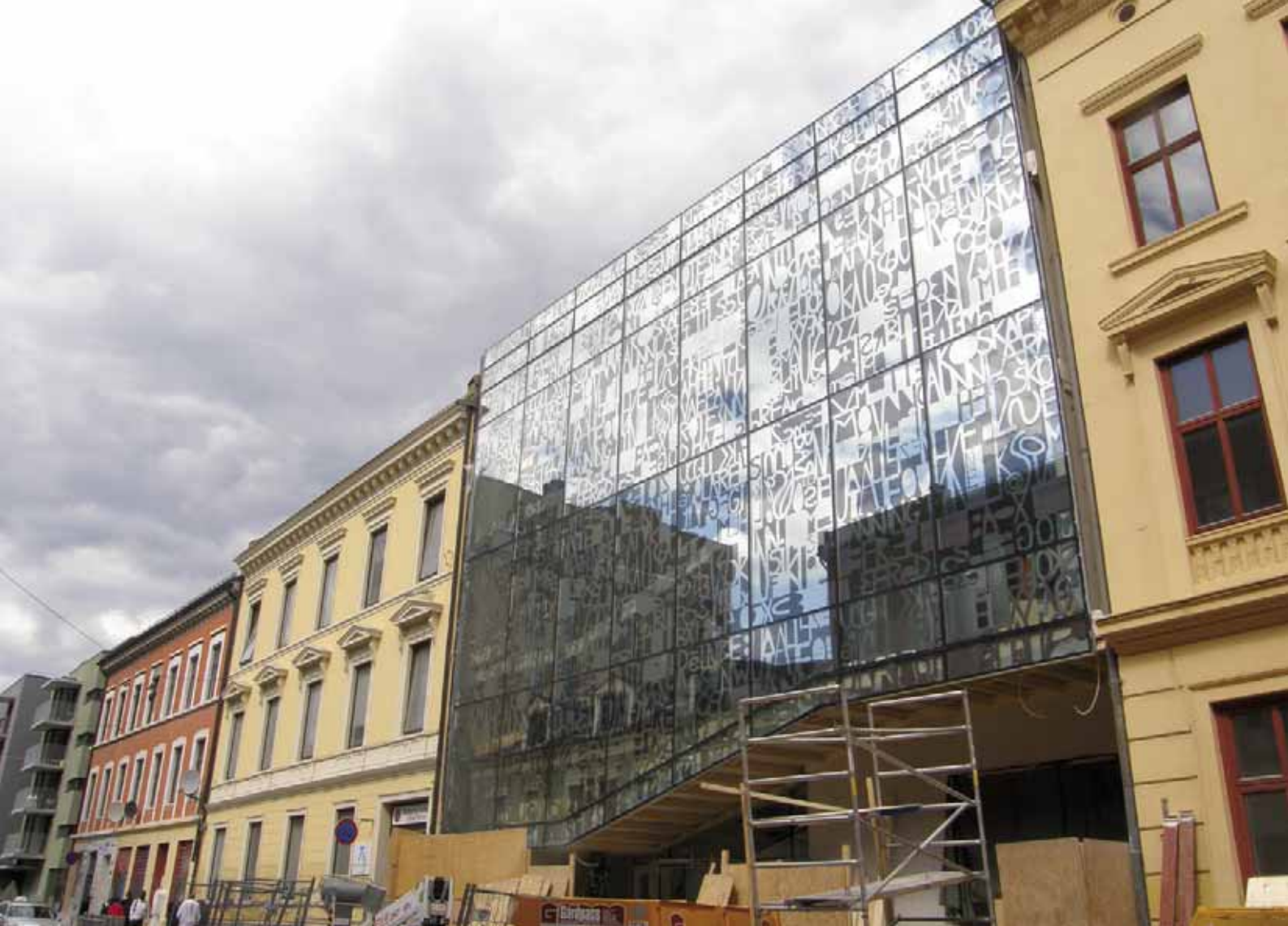
Osterhaus gate nr 4a, infill av boliger under oppførelse, Arkitekt: Element arkitekter 2009
