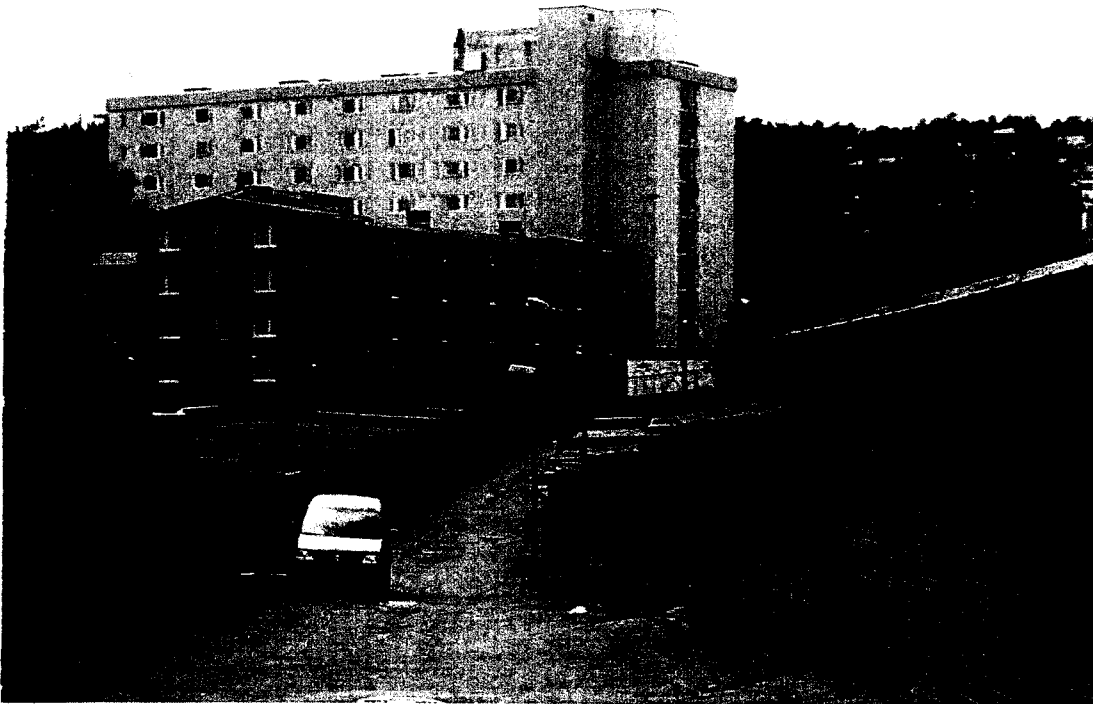
Tomten med eksisterende garasjer, og Ryen eldrebolig bak.
