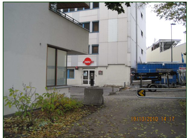
NAV St. Hanshaugen, Pilestredet 56.
