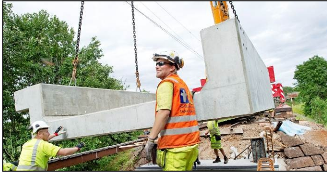
NY BETONGBRU SETTES INN PÅ SPIKKESTADBANEN. FOTO: HILDE LILLEFJORD.
