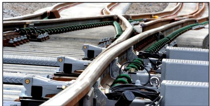
NYE SPORVEKSLER MED BEVEGELIG KRYSS, BRYNSBAKKEN. FOTO: ØYSTEIN GRUE
