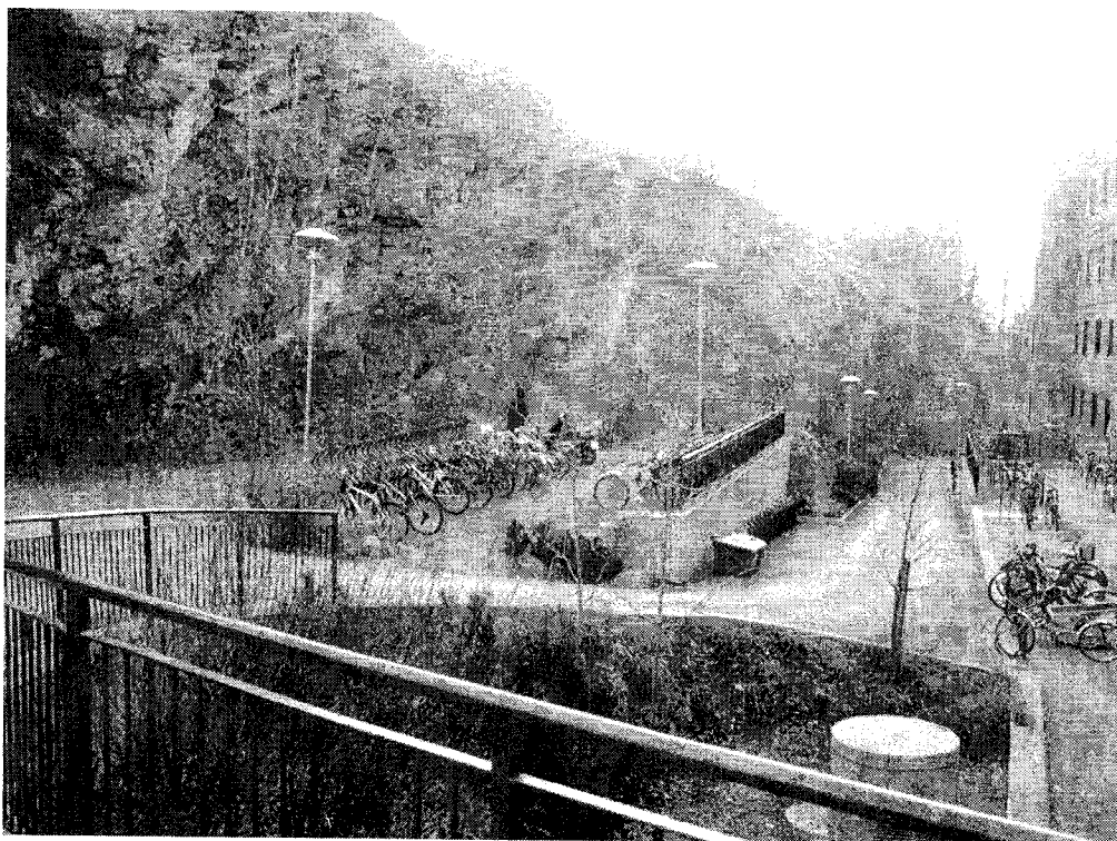
Foto sett mot sørøst med sykkelparkering og usikret fjellskrent i midten og sikret fjellskrent på høyre side.
