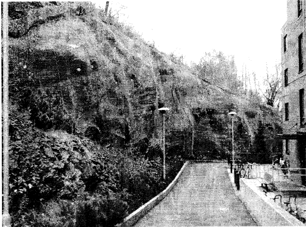
Figur 14 Søndre skjæring bak nummer 9
