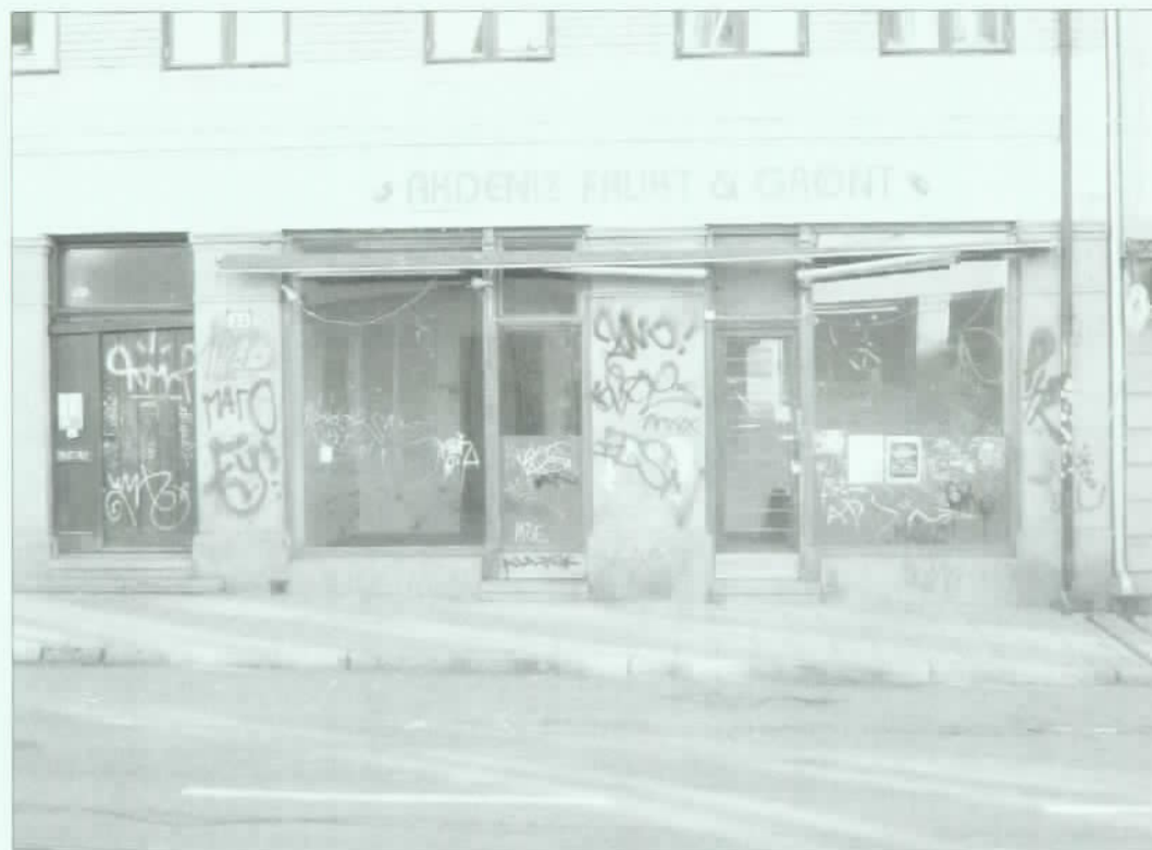
EKSISTERENDE FASADE MOT THORVALD MEYERS GATE (BILDE)
