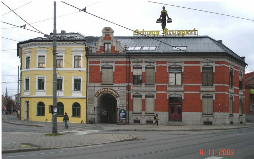
Fasade syd, ingen endringer
