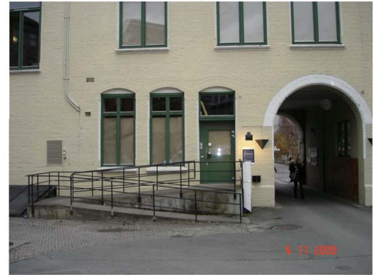
Fasade nord viser eksiterende adkomst for rullestoler og varelevering
