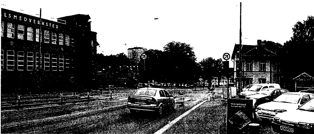
Område sett fra nord i Trondheimsveien
